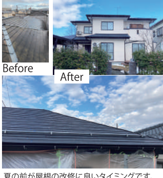
夏の前が屋根の改修に良いタイミングです。
